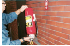
▲消火器具点検
