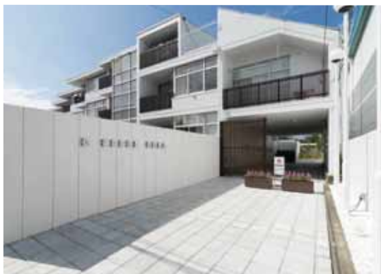
元の外観を活かしつつ、入口にはコンクリート平板を敷き、外壁を塗装。高級感漂う明るいエントランスに改修
